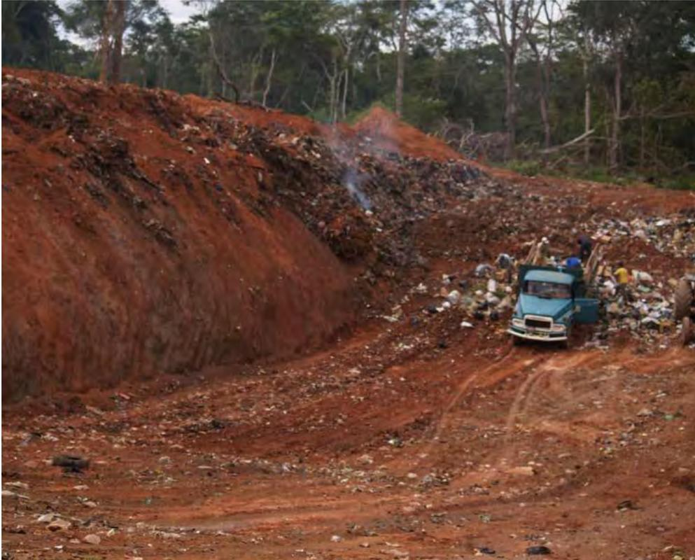
Defectuosas, por falta de correspondencia, las alturas de los taludes. Se colmatará antes en el fondo de vertedero. Difícil solución
